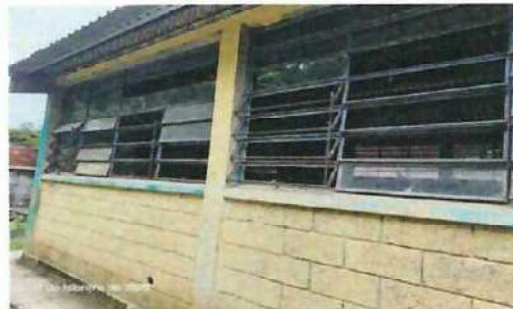
Foto 2: Se Observa vidrios quebrados n modulo No. 1
