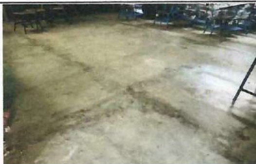
Foto 6: Se observa deterioro en el piso del modulo No. 1
